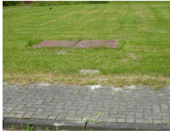
Abdeckung der Zisterne
