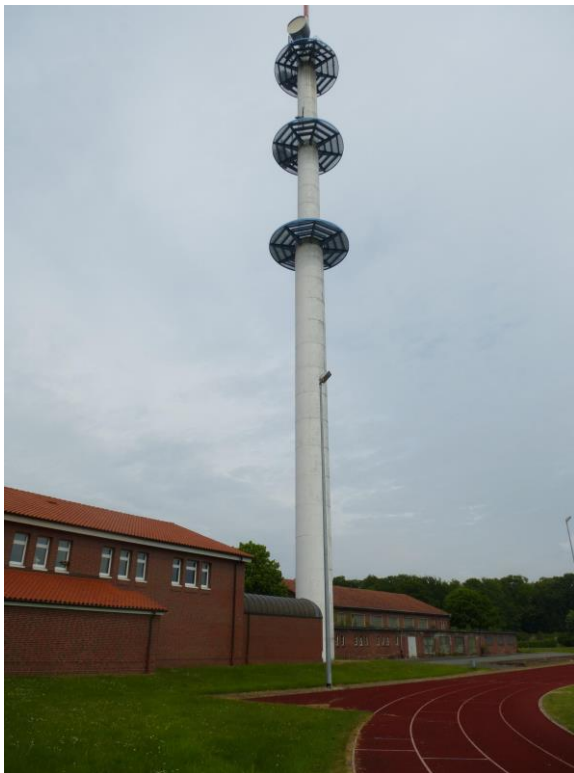
Funkturm mit Nebengebäude (links neben dem Turm)
