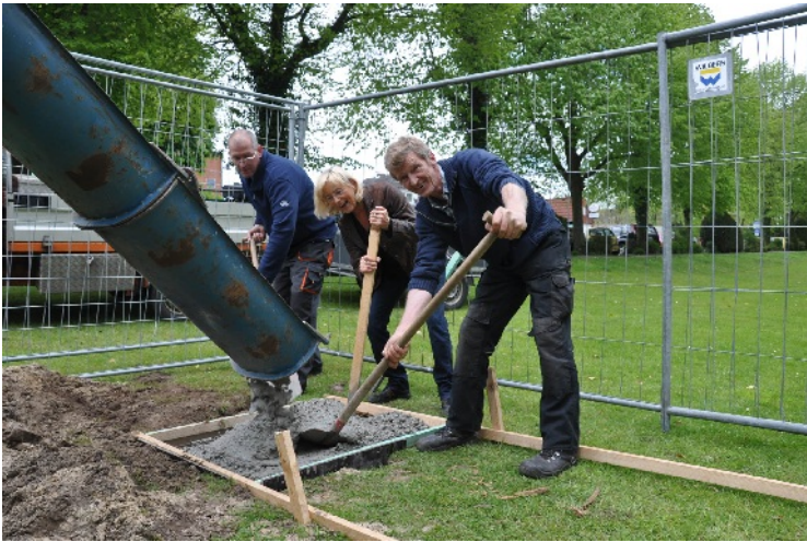
Walter Hayenga und Michael Janssen verteilen zusammen mit Renate Ruck den Beton für das Fundament des Julianen-Tores am Georgswall.
