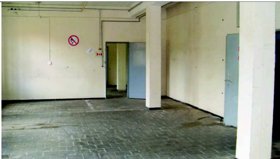
KVF Nr. 8: Geb. 17, ehem. Elektrowerkstatt/Malerei Datum: 26.06.2013
