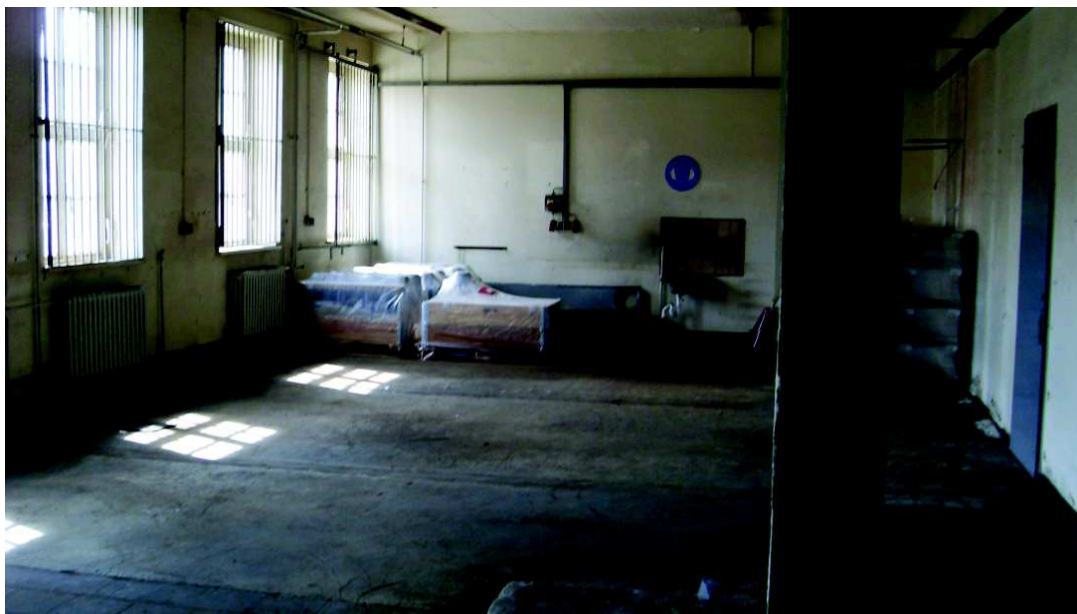
KVF Nr. 10: Geb. 17, ehem. Schlosserwerkstatt Datum: 26.06.2013
