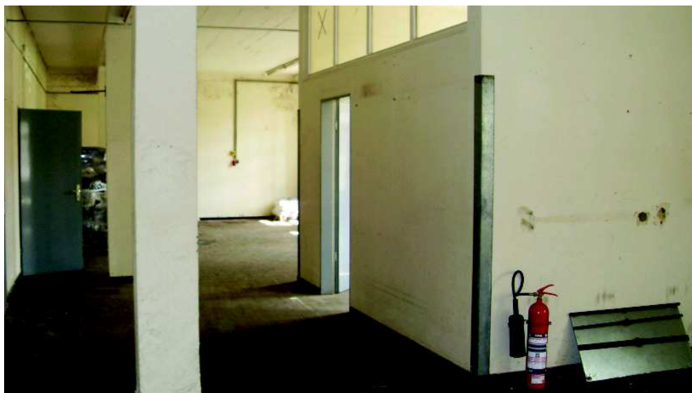
KVF Nr. 9: Geb. 17, ehem. Schreinerwerkstatt Datum: 26.06.2013
