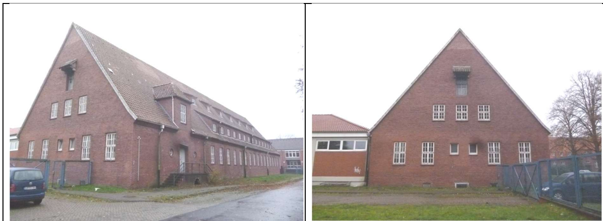
Gebäude Nr. 17 Baudenkmal südlich Quartiersplatz
