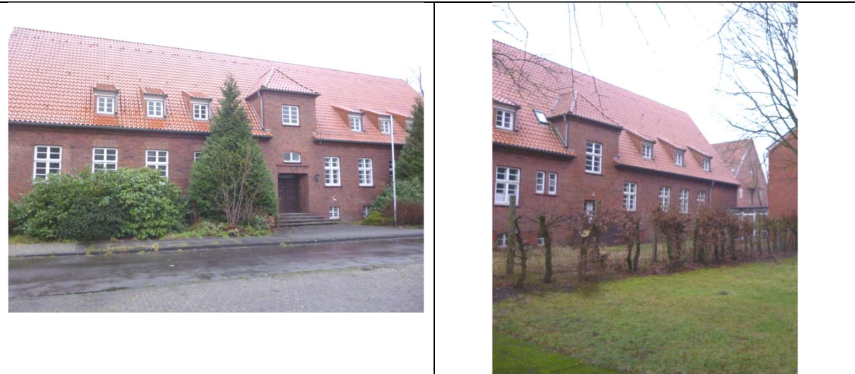
Gebäude Nr. 18 Baudenkmal westlich Quartiersplatz
